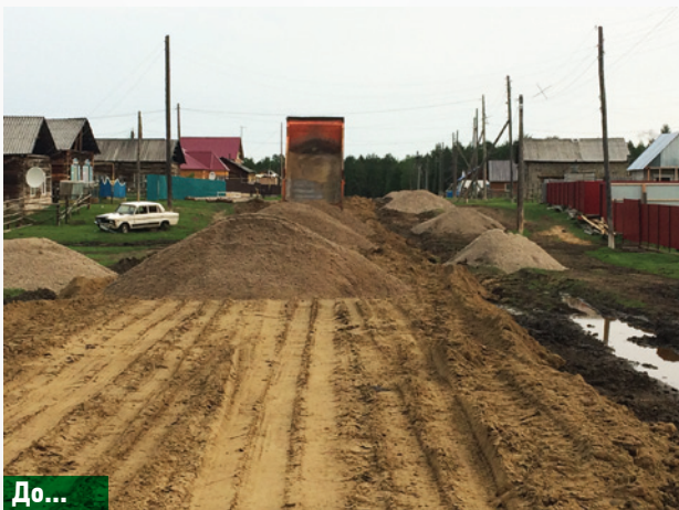
Восстановление поперечного покрытия и ровности проезжей части автомобильной дороги, Кентикский наслег Кобяйского района.
